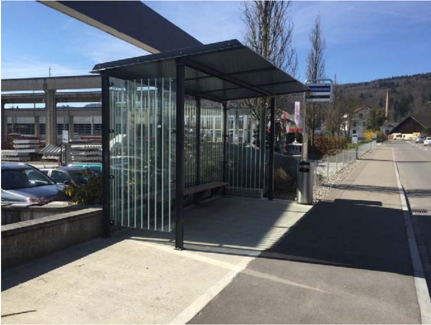
Bushaltestelle Wohlerstrasse mit neuem Buswartehäuschen
