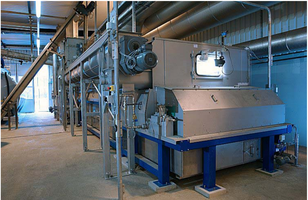
Schlammtrocknungsanlage
