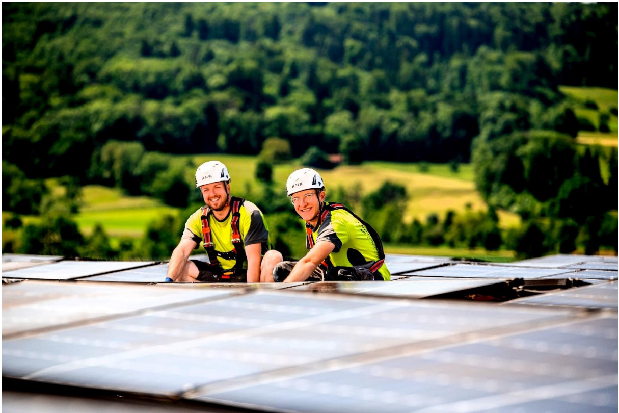
Installation einer Photovoltaikanlage / Foto: Gemeindewerke Villmergen (GWV)
