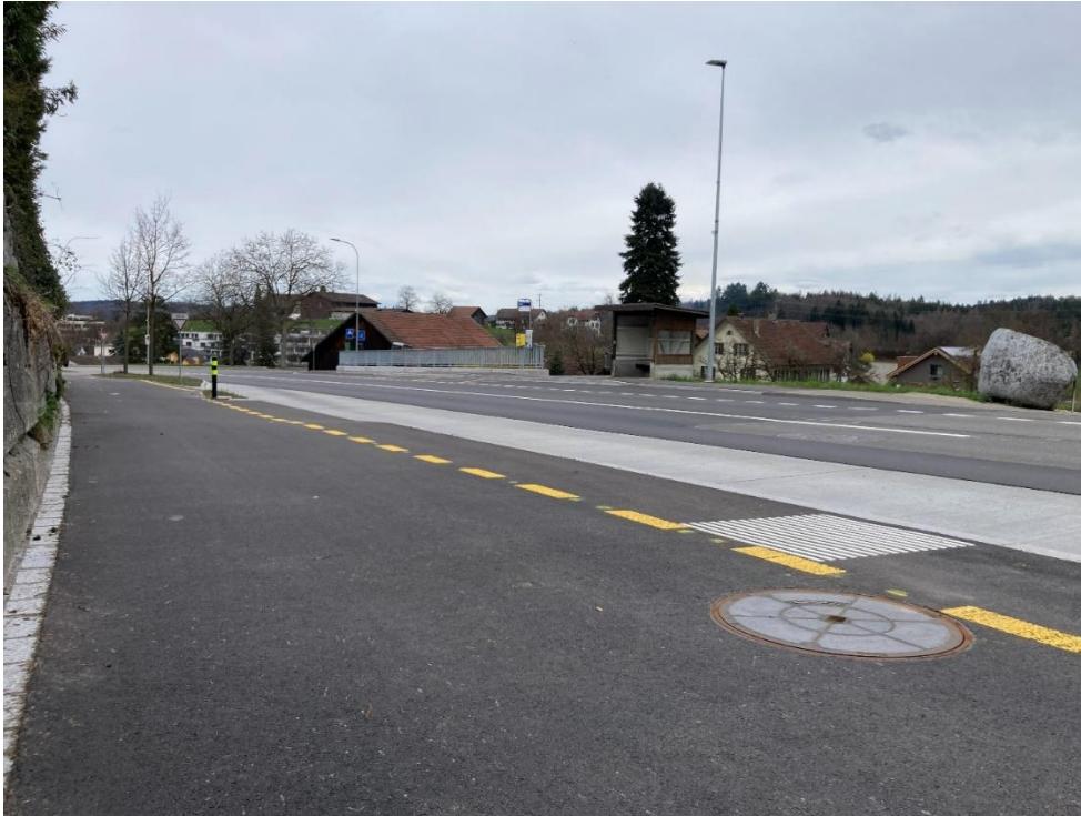
Hilfikerstrasse mit Bushaltestelle / Foto: Bauverwaltung
