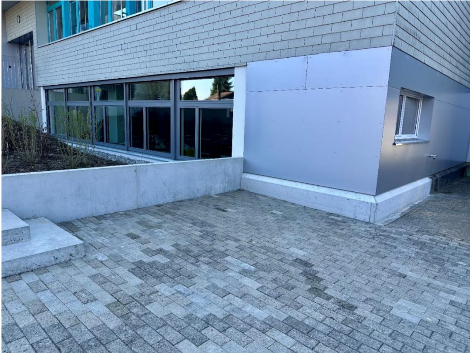
Umbau und Umnutzung IT-Labor zu TTG-Zimmer (ausser) / Foto: Bauverwaltung
