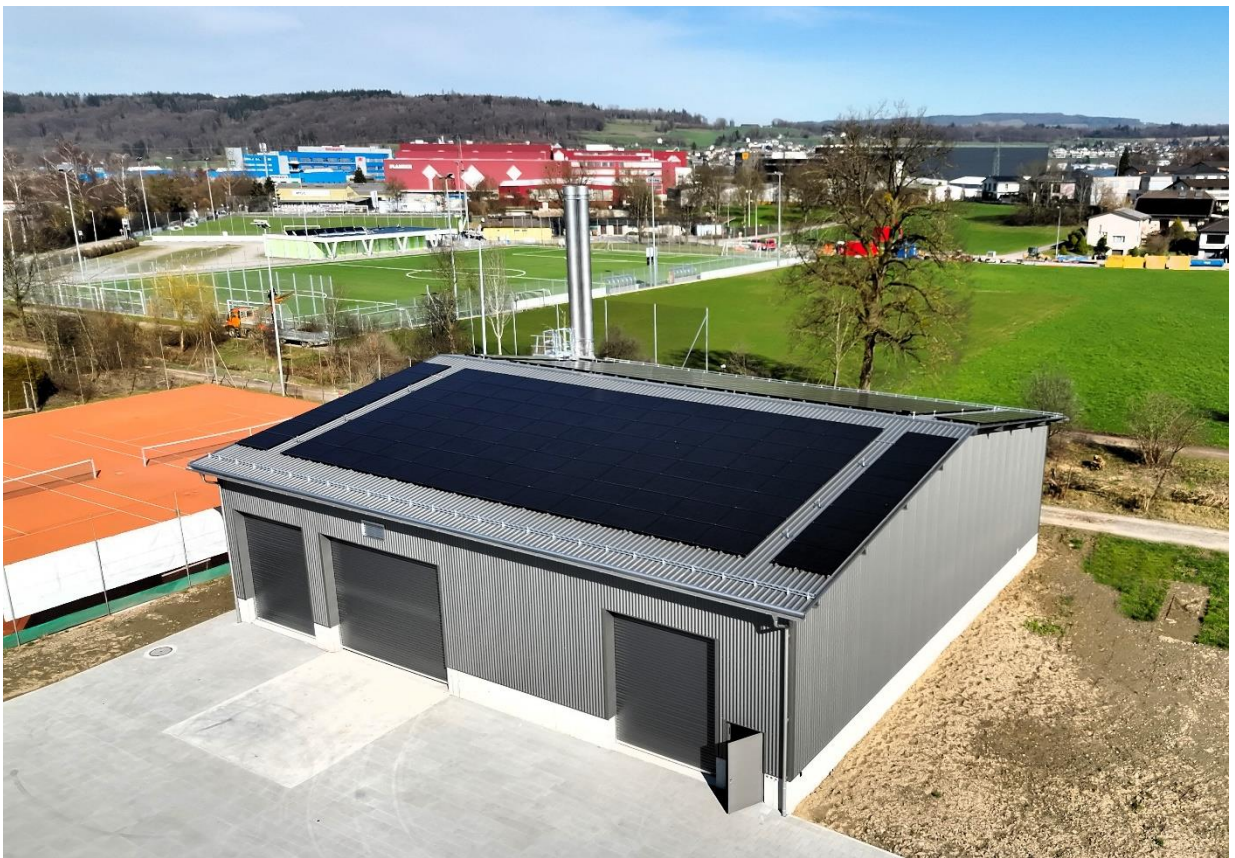
Wärmezentrale / Foto: Gemeindewerke Villmergen (GWV)
