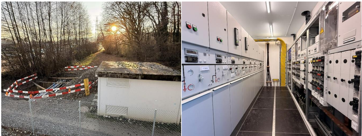
Trafostation Torbehölzli vorher und nachher / Fotos: Gemeindewerke Villmergen (GWV)
