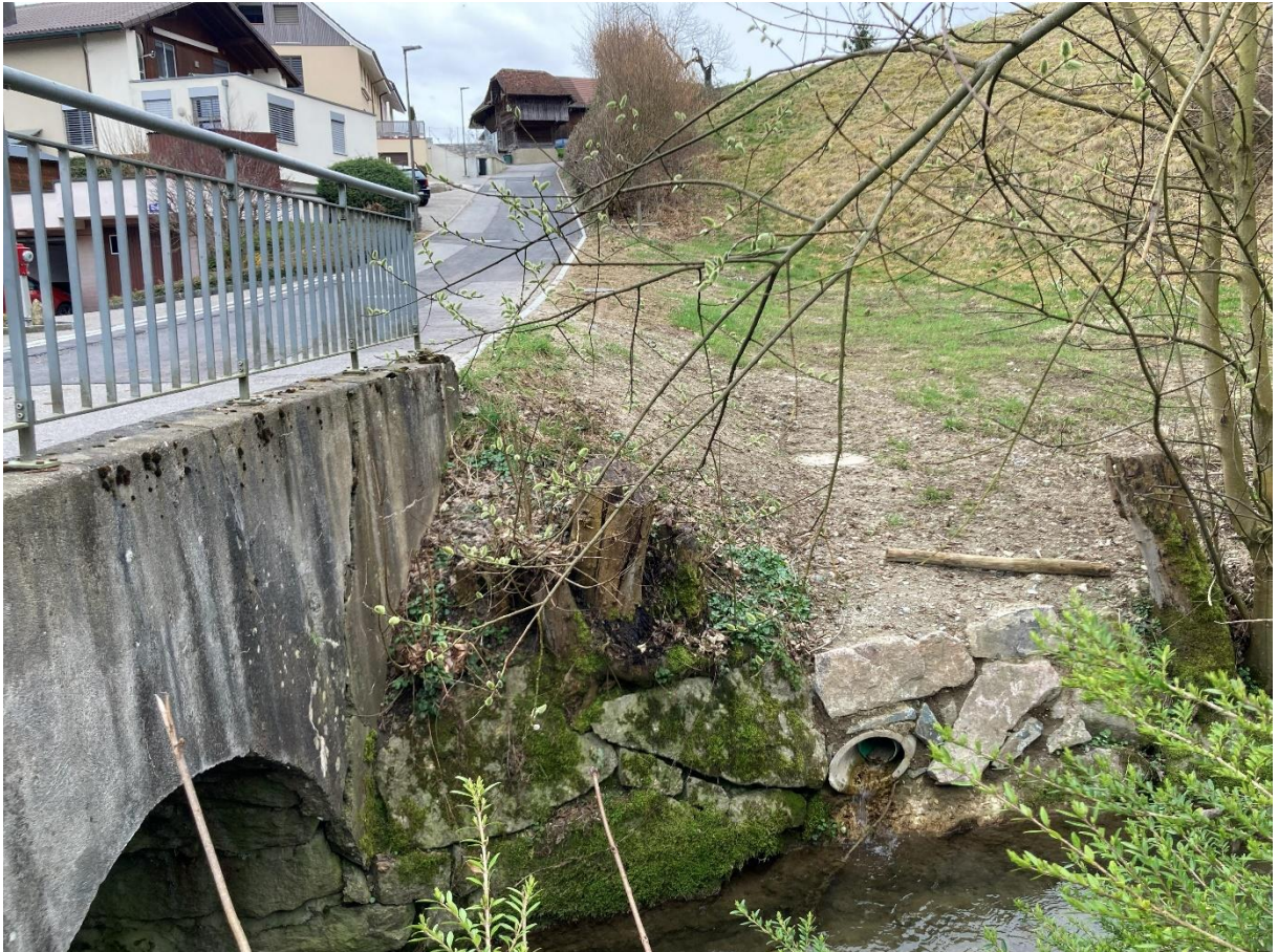
Poststrasse / Foto: Bauverwaltung
