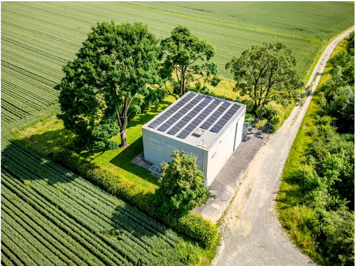
Photovoltaikanlage auf dem Dach des Grundwasserpumpwerks Kreuzester Foto: Gemeindewerke Villmergen (GWV)
