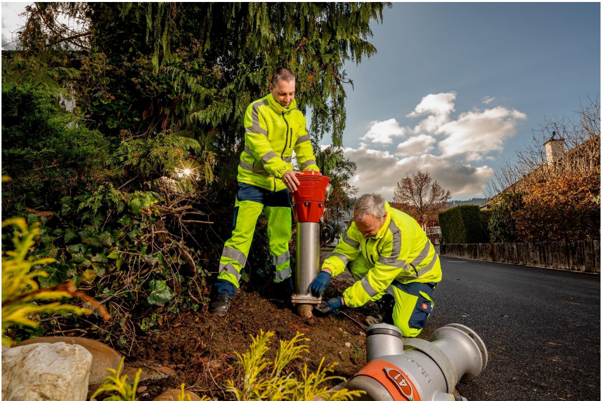
Erneuerung Hydrant / Foto: Gemeindewerke Villmergen (GWV)
