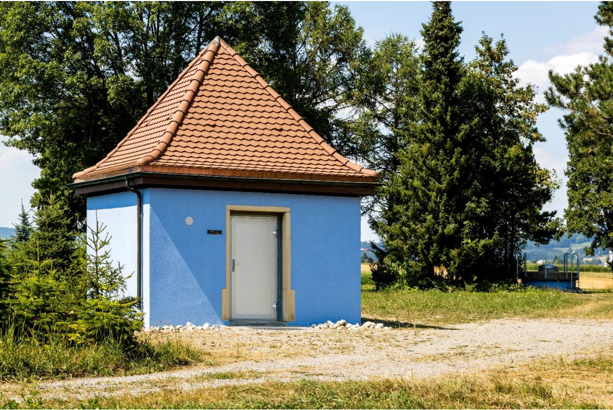
Grundwasserpumpwerk Unterzelg / Foto: Gemeindewerke Villmergen (GWV)
