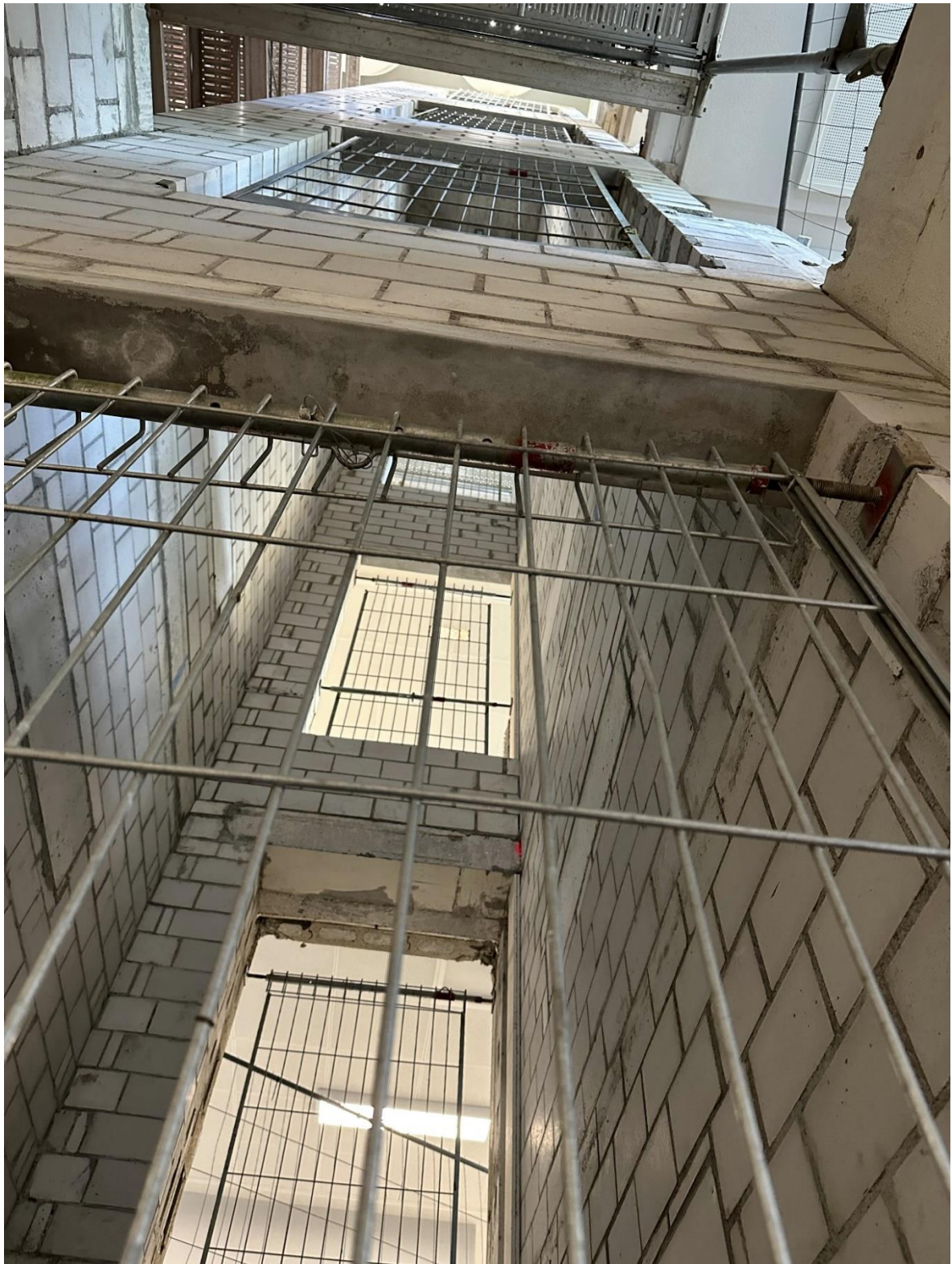
Neubau Lift / Foto: Bauverwaltung
