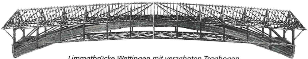
Limmatbrücke Wettingen mit verzahnten Tragbogen
