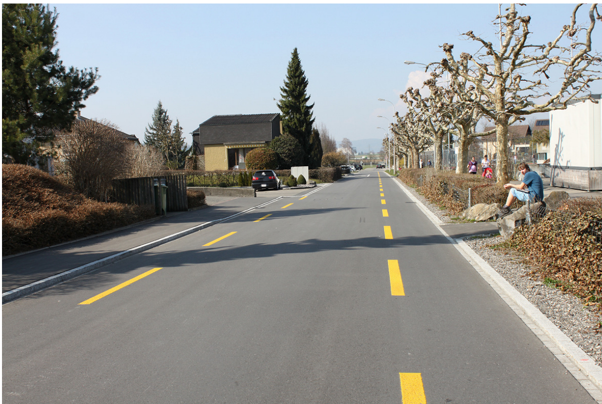
Die sanierte Dorfmattestrasse
