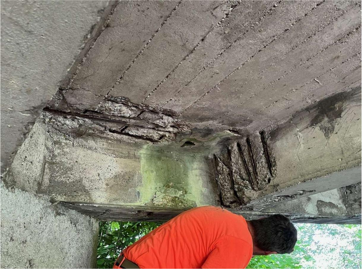
*Beschädigte Brückenplatte / Foto: Bauverwaltung*
