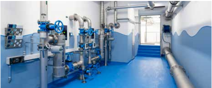
Reservoir Bergmättli, Innenansicht des neuen Teils. Foto: Gemeindewerke Villmergen (GWV).
