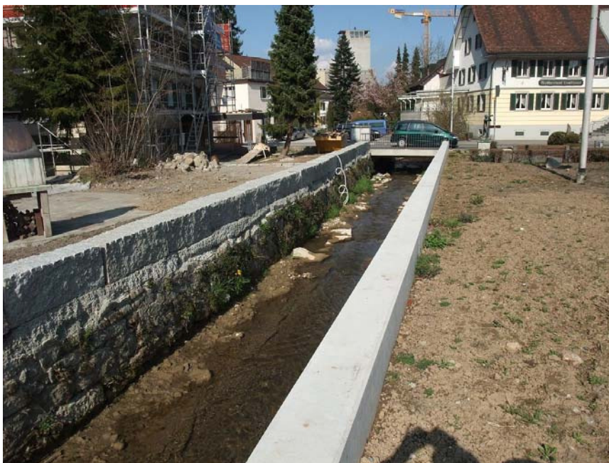
Staudamm und Massnahmen am Unterlauf
