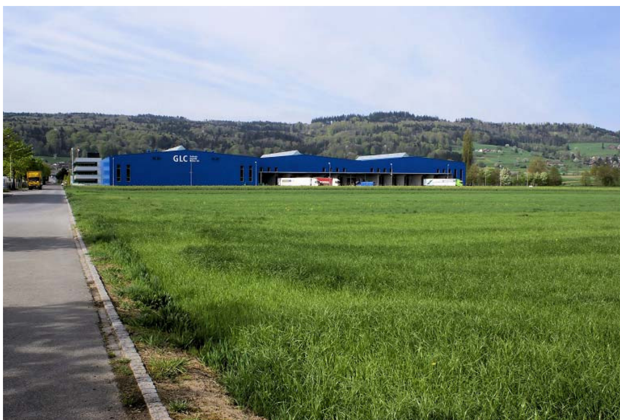
Baulandgrundstücke im Industriegebiet „Allmend“
