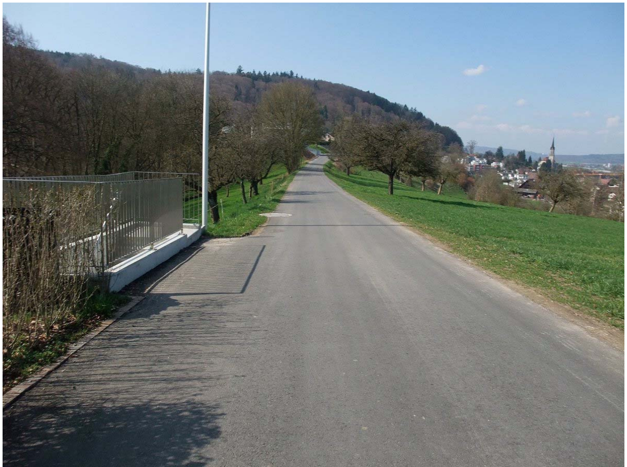
Die sanierte Weingasse
