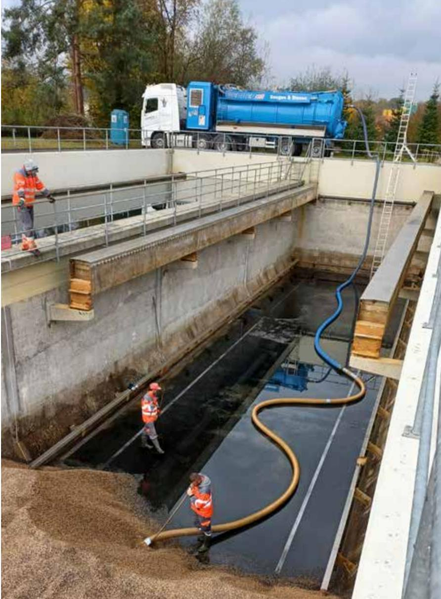
*Eingelagerte Biologiefüllkörper werden gepumpt. Foto: ARA «Im Blettler».*
