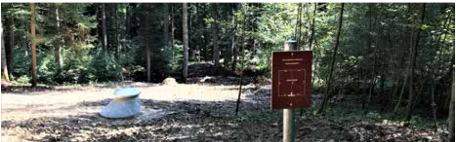
Sanierung/Ersatz Quelfassung Beuchau. Foto: Gemeindewerke Villmergen.
