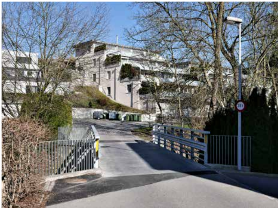
Die das Quartier Challemtatt, Hilfikon, über den Erusbach erschliessende neue Brücke. Foto: Gemeindekanzlei.
