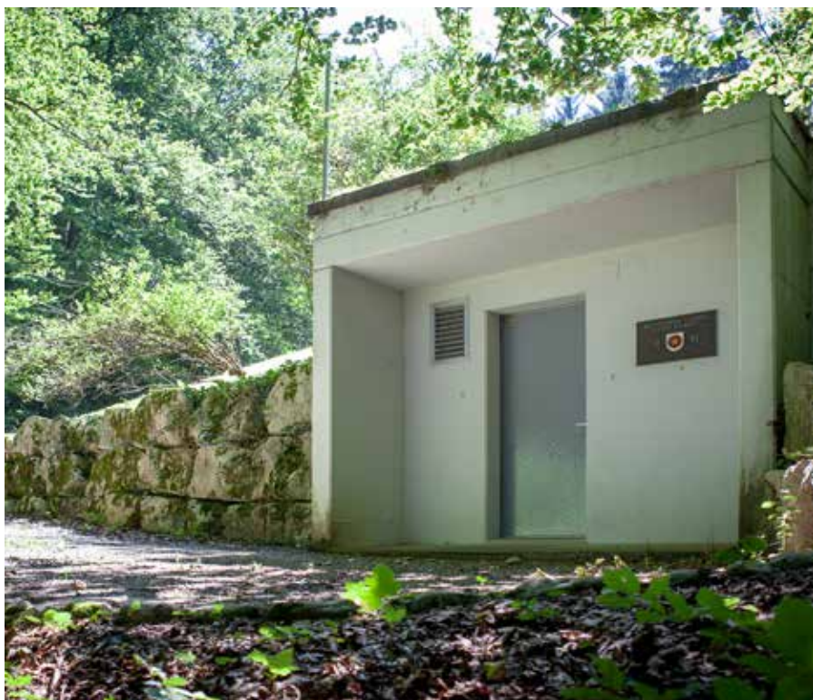
Bestehendes Reservoir Bergmättli, Baujahr 1993.
