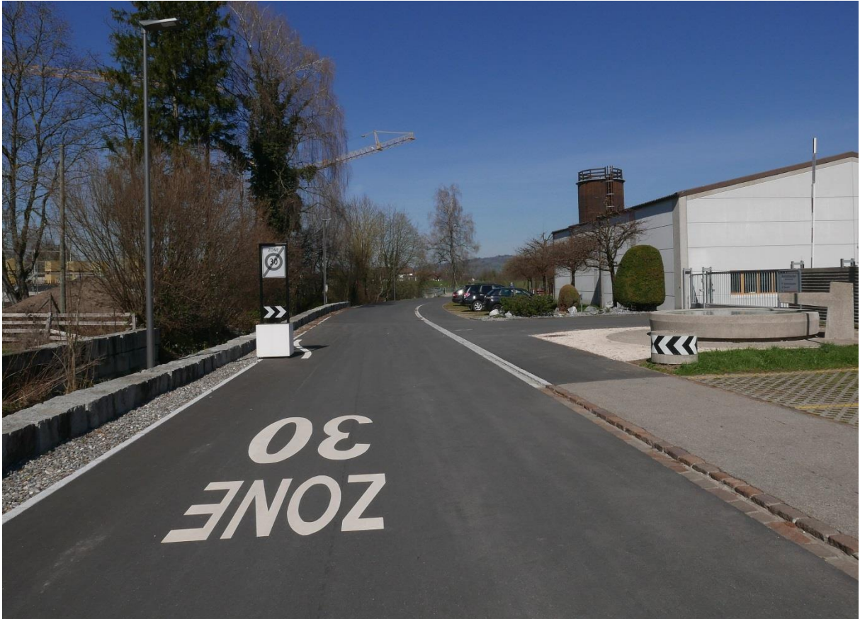
Sanierte Bachstrasse mit neuem Belag
