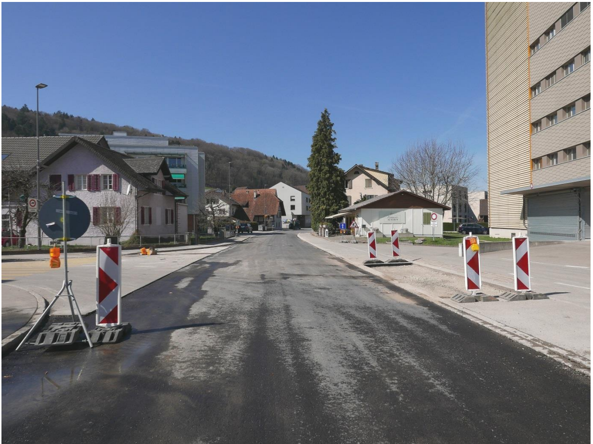
Alte Bahnhofstrasse, 1. Etappe
