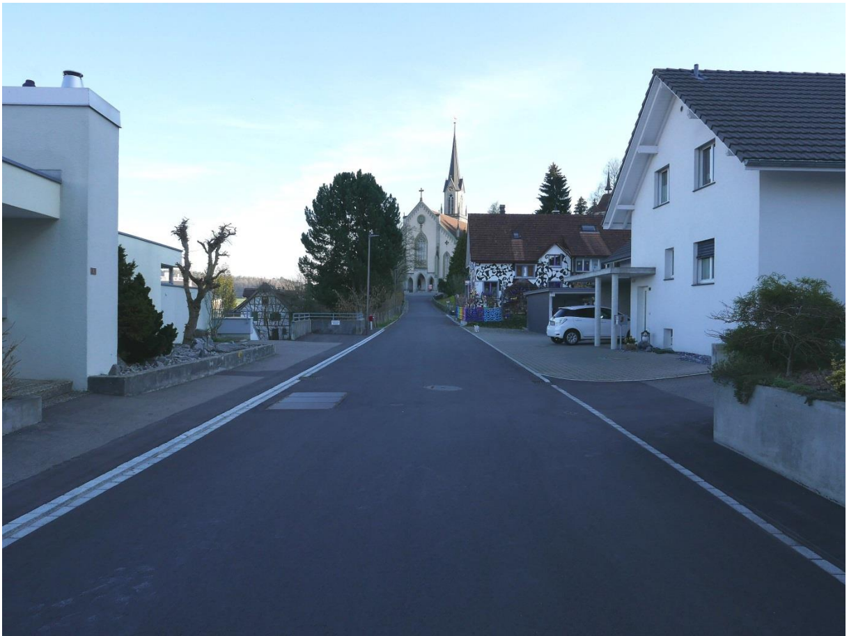
Sanierte Kirchgasse mit neuem Belag
