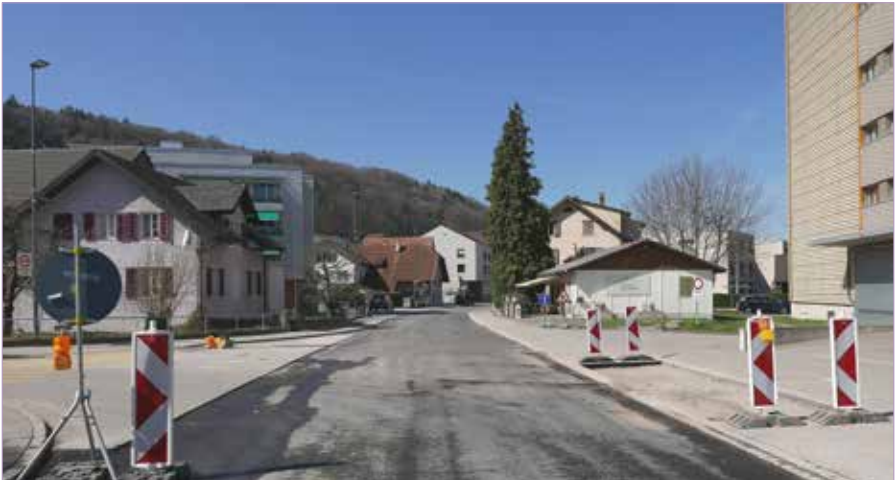
Alte Bahnhofstrasse, Belagssanierung 1. Etappe
