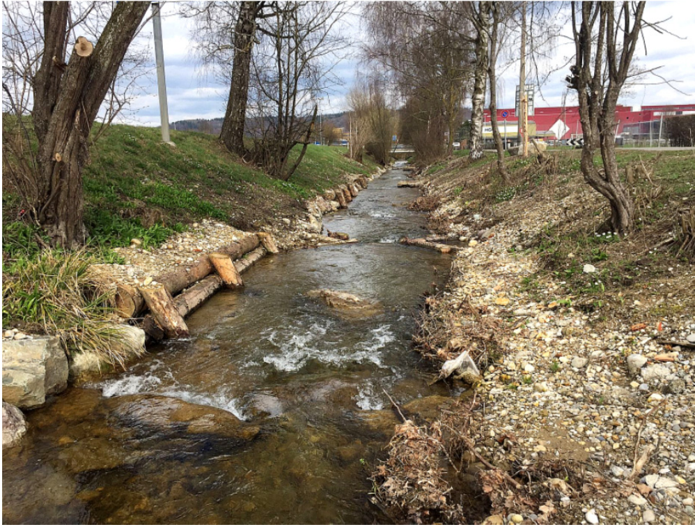
Neu gestalteter Holzbach
