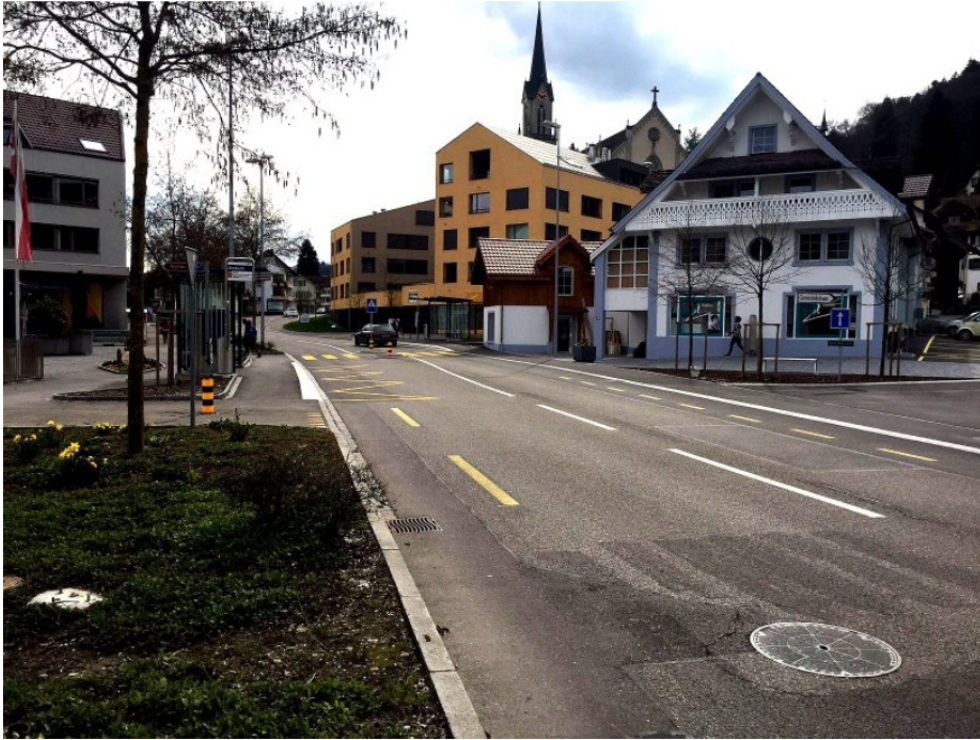
Mitteldorfstrasse (K 252) mit neuen Bushaltestellen und Buswartehäuschen
