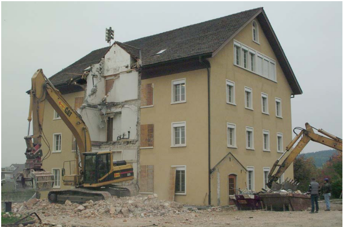
Start Umbau und Erweiterung des Gemeindehauses
